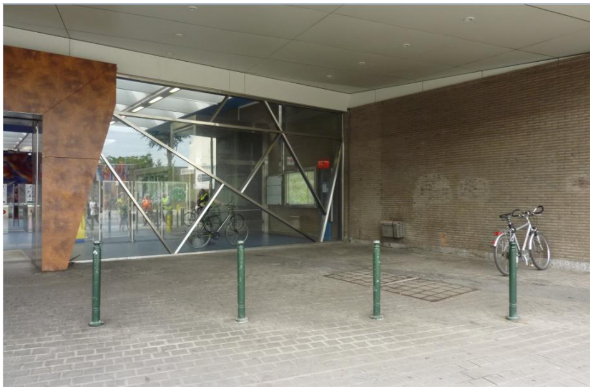
Niet-overdekte ruimte zonder specifiek gebruik in de directe omgeving van het metrostation Hankar
